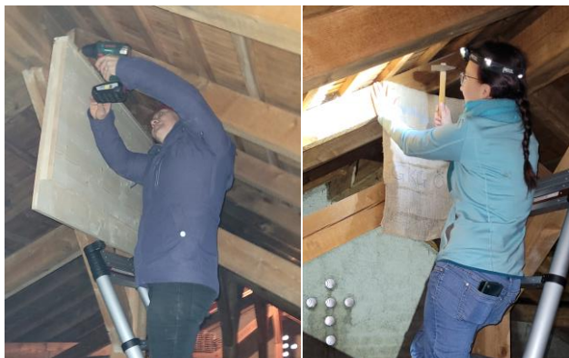
Anbringen von Spaltverstecken im Dachstock (Fotos: Pascale Hutter und Céline Martinez-Ernst).
